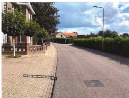
grijze betonsteen zorgt voor duidelijke scheiding verkeersstromen
