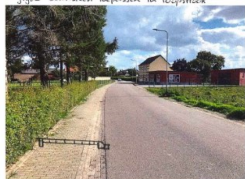
trottoirband + grijze betonsteen zorgt ervoor dat er een duidelijke loopstrook is, waarop niet geparkeerd mag worden!
