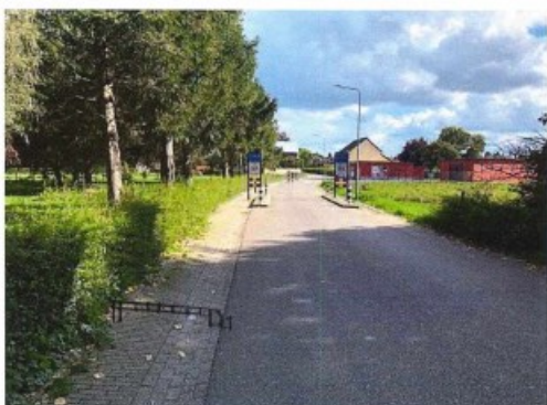
kantopsluiting aanbrengen (8x20 band)
