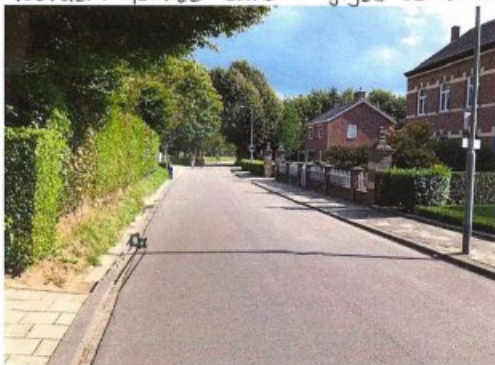
trottoirband aansluiten op bestaand
