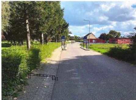
kantopsluiting aanbrengen (8x20 band)
