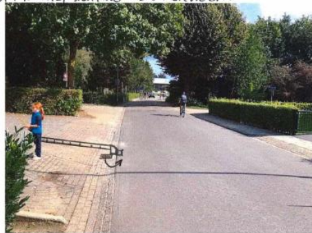
schuine band (5/20x20) zodat inrit bereikbaar bij grijze betonsteen tussen in loopstrook
