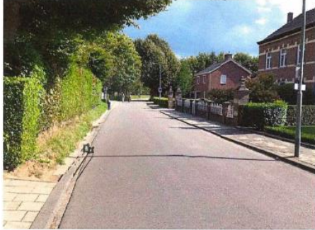
trottoirband aansluiten op bestaand
